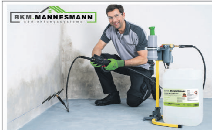
Ausführen einer nachträglichen Horizontalsperre mittels BKM Mannesmann Injektionssystem
